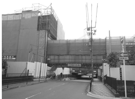
A・B地区を結ぶ上空通路
